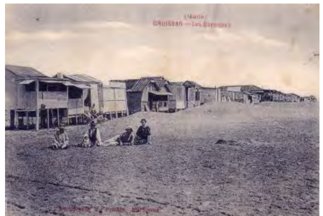
La plage de Gruissan avant aménagement / E. Prunot
